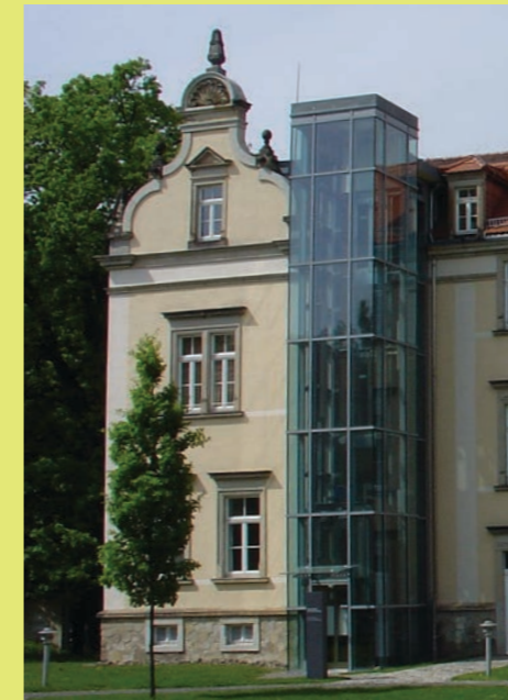
Der Aufzug ist an die Gedenk-Stätte angebaut.
